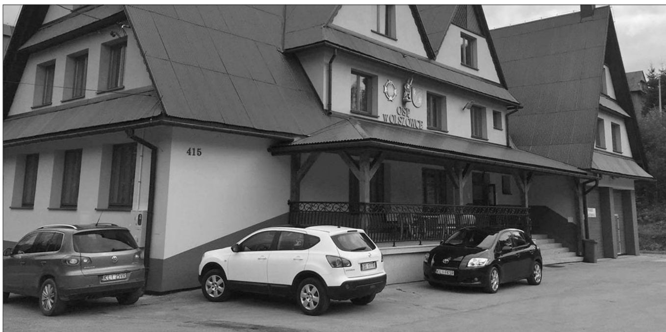
Odnowiona remiza w Olszówce
