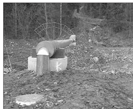
Kanalizacja w Kasince Małej
