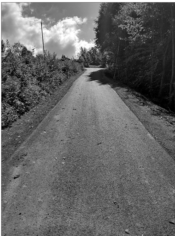
Odnowiona droga rolnicza w Kasince Małej – Widziszcie Górne
