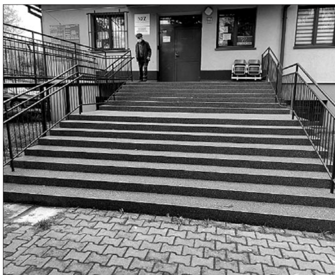
Wyremontowane schody do Ośrodka Zdrowia w Kasinie Wielkiej
